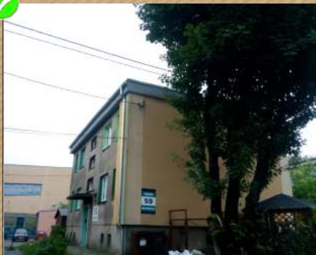
Łukasieńskiego 59 - termomodernizacja dachu, gzymsów wraz z wykonaniem nowej powłoki dachu.
