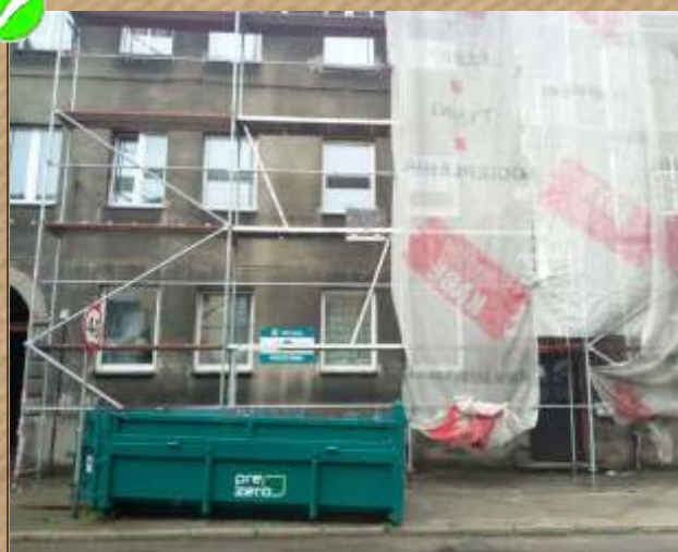
Pocztowa 2 - awaryjna naprawa komina wraz z częścią dachu z dachówki
