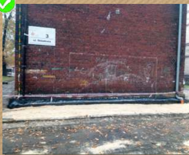
Składowa 3 - wykonanie izolacji pionowej budynku od strony południowej
