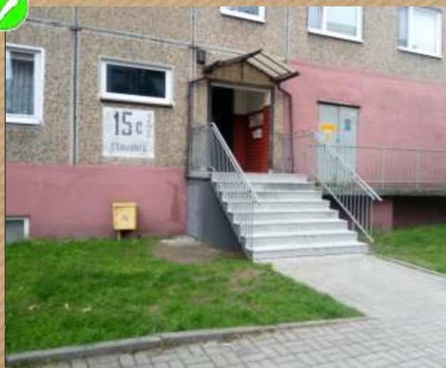
Stawowa 15c - remont schodów wejściowych
