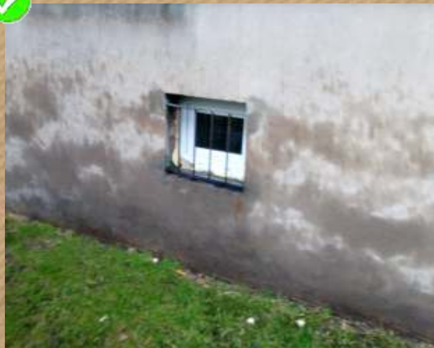
Michałkowicka 46 - wymiana okienek piwnicznych
