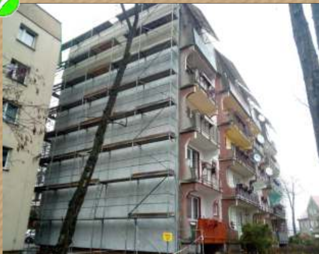
Katowicka 24 i 26 - termomodernizacja
