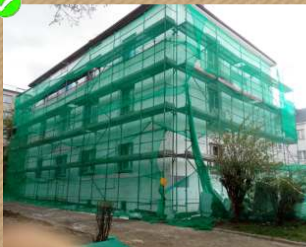
Pocztowa 4b - termomodernizacja
