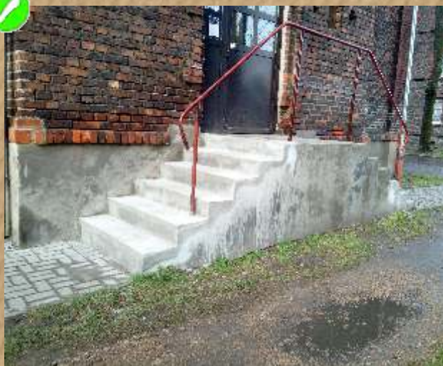
Boh. Westerplatte 28D - awaryjna naprawa schodów zewnętrznych
