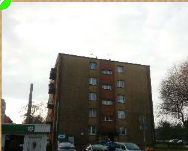
Michałkowicka 44 - docieplenie stropodachu
