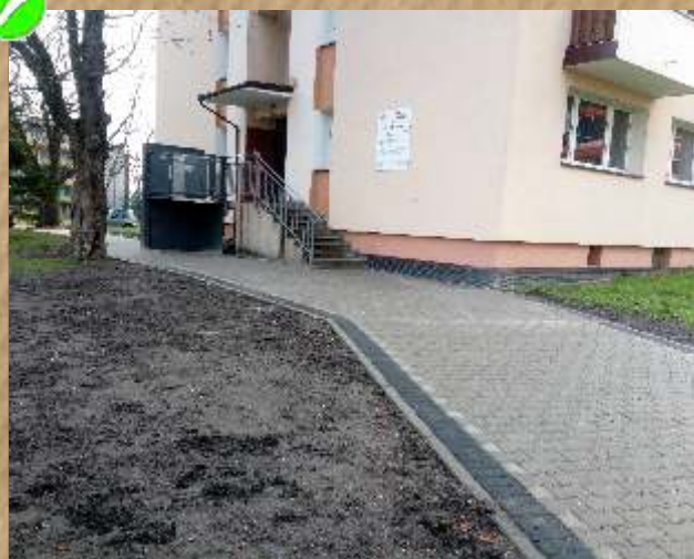
Stawowa 3-3a - wykonanie chodników i podjazdów pod budynek
