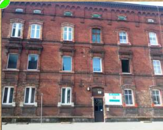
Michałkowska 32 - przymurowanie nadproży nad oknami
