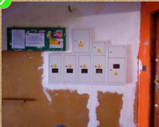
Bytomska 17 - wymiana instalacji elektrycznej na klatkach schodowych
